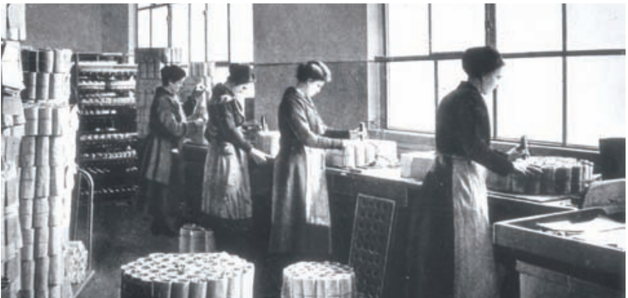
Schon immer war die Prüfung der Lampen vor dem Versand ein wichtiger Arbeitsschritt. Anfang der Zwanziger Jahre des letzten Jahrhunderts war dies eine sehr aufwändige Handarbeit.
