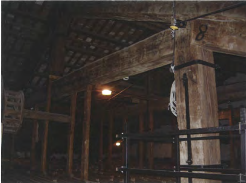
Fig. 4.91 - Teatro La Nuova Fenice, Osimo (AN). Doppio intaglio nel monaco che accoglie il sottopuntone e la controcatena.
