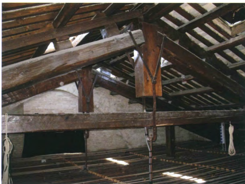
Fig. 4.88 - Teatro La Nuova Fenice, Osimo (AN). Il monaco presenta un'estensione maggiore in altezza dei puntoni e l'unione è rinforzata da staffatura metallica risvoltata sui puntoni e collegata nel monaco.
