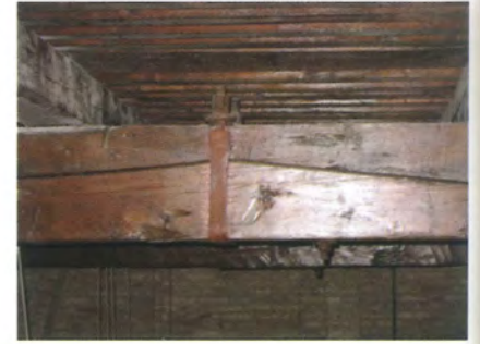
Fig. 4.99 - Teatro di Osimo (AN). Particolare della catena.
