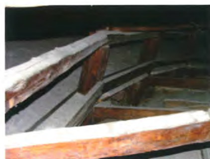
Fig. 4.37 – Sistema di raccordo delle candele e delle centine. Teatro Pergolesi di Jesi (AN).
