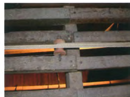
Fig. 6.6 – Teatro di Montemarciano (AN). Particolare del collegamento chiodato estradossale degli elementi in legno che compongono il graticcio.
