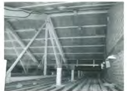
Fig. 2.7 - Teatro Mercantini di Ripatransone (AP). Intervento di fine anni '70 di sostituzione delle capriate lignee con capriate in acciaio.
