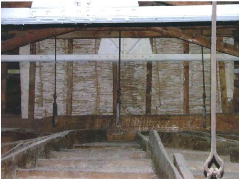
Fig. 6.25 – Sulla sinistra dell'immagine si scorge il cesto del lampadario del Teatro Gentile di Fabriano (AN) realizzato in legno e camorcanna.
