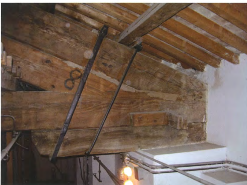
Fig. 4.83 - Teatro Gentile, Fabriano (AN). Unione a doppio dente per il sottopuntone e a dente semplice per il puntone.
