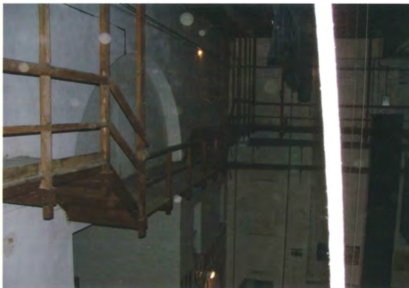
Fig. 6.10 – Teatro di Fabriano (AN). Il ballatoio che sovrasta il palcoscenico. Da notare le mensole in legno sporgenti dalla muratura e i tiranti sempre in legno che lo sorreggono.
