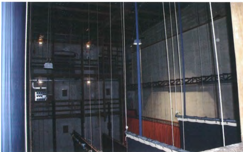
Fig. 6.12 – Teatro di Jesi (AN). Passerella sospesa alle strutture di copertura.
