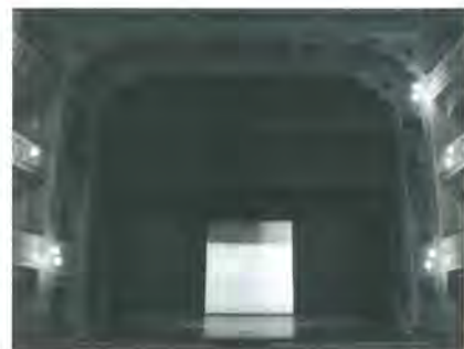
Fig. 5.11 - Arco di proscenio, Teatro La Nuova Fenice di Osimo (AN). I palchi posti al di sotto dell'arco riducono l'effetto delle prime riflessioni laterali.
