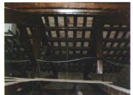
Fig. 4.74 - Esempio di armatura semplice presente nel Teatro di Sirolo (AN).
