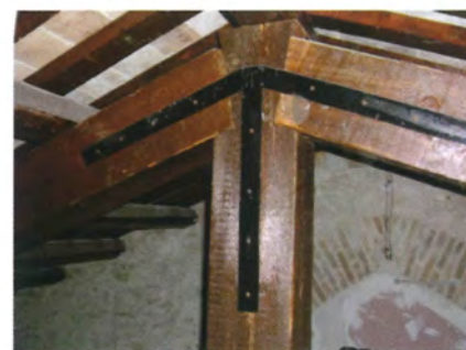
Fig. 4.89 - Teatro di Sirolo (AN). Unione a dente semplice rinforzata da fasce metalliche collegate in entrambi i lati.
