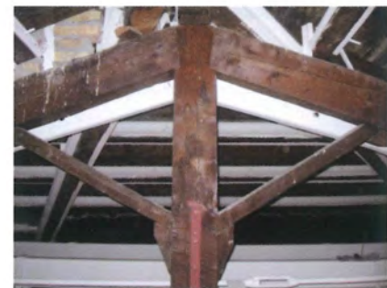
Fig. 4.108 - Teatro Ferrari di S. Marcello (AN). Né il monaco né il puntone risultano intagliati. L'unione avviene mediante sottomisure lignee.
