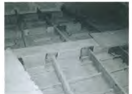
Fig. 2.8 - Teatro Comunale di Montecarotto (AN). Si nota l'applicazione di materiale composito all'estradosso del plafone con una fascia larga mediamente 70 cm posta in opera in direzione ortogonale ai tambocchi e alla catena della capriata.
