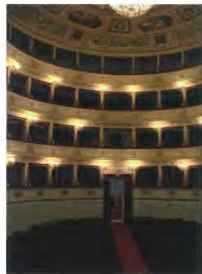
Fig. 4.23 – Il basamento del Teatro Pergolesi di Jesi sorregge i tre ordini di palchi più il loggione a galleria.
