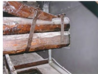
Fig. 4.81 - Teatro Misa di Arcevia (AN). In questo caso l'unione è a semplice dente cuneiforme. Da notare come la catena non sia rifilata.
