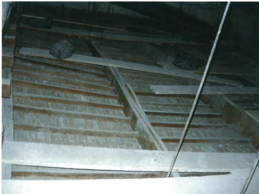
Fig. 4.56 - Centinatura formata da tre tavole accostate controventata da sottomisure lignee (Teatro dei Filarmonici di Ascoli Piceno).
