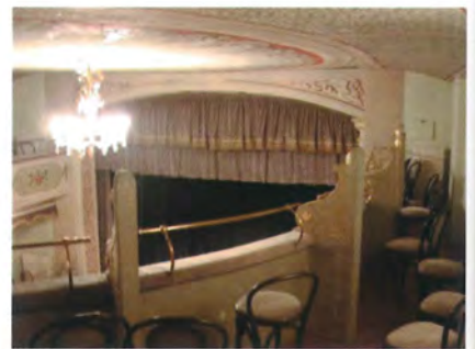
Fig. 4.54 e Fig. 4.55 - Teatro di San Marcello (AN). Loggione a balconata. La struttura delle candeie dei palchetti non raggiunge la sommità del plafone.
