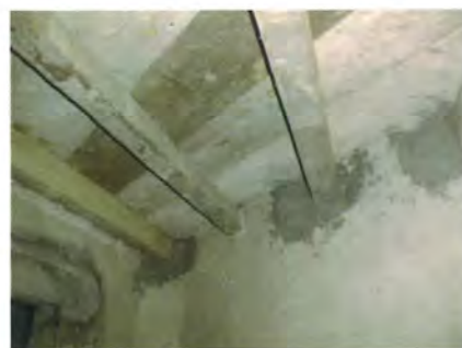
Fig. 4.36 – Appoggio nella muratura dei "travetti zoppi". Teatro Gentile di Fabriano (AN).
