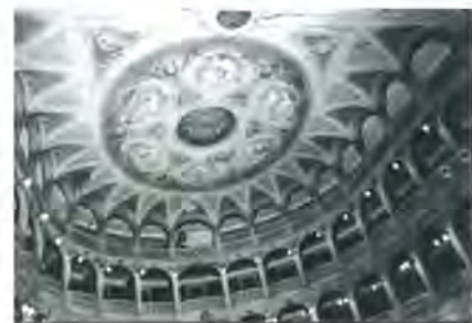
Fig. 1.1 – Il teatro Lauro Rossi di Macerata. Particolare dei palchetti realizzati con architravi arcuati (fonte: Biblioteca Comunale Mozzi-Borgetti di Macerata)
