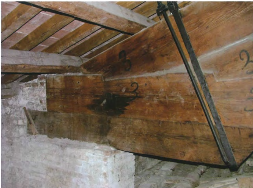
Fig. 4.81 - Teatro Misa di Arcevia (AN). In questo caso l'unione è a semplice dente cuneiforme. Da notare come la catena non sia rifilata.
