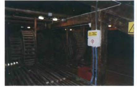
Fig. 6.23 – Ruote in legno poste sul graticcio del palcoscenico del Teatro di Cagli (PU).
