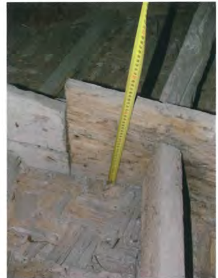
Fig. 4.50 - Dettaglio della giunzione fra tavole. Si nota anche la stuoia di canne a tessuto intrecciato. Teatro Gentile di Fabriano (AN).
