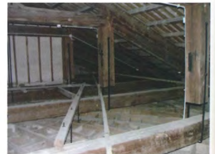
Fig. 6.25 – Sulla sinistra dell'immagine si scorge il cesto del lampadario del Teatro Gentile di Fabriano (AN) realizzato in legno e camorcanna.
