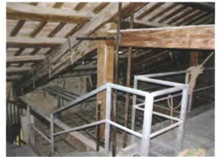
Fig. 4.95 - Teatro di S. Ginesio (MC). Presenza di una sottomisura in legno sopra il monaco a rafforzamento del nodo.
