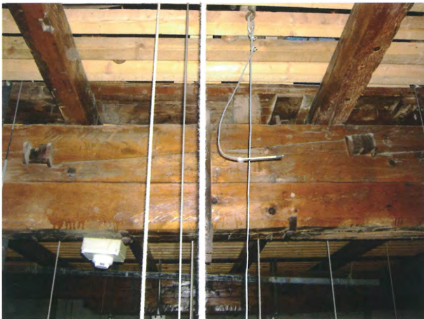
Fig. 4.101 - Teatro Lauro Rossi, Macerata. Catena composta da due elementi separati fasciati con bandelle metalliche. La giunzione avviene mediante sovrapposizione sopra e sotto la discontinuità di due elementi in legno forzati da staffature metalliche a vite.
