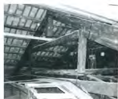
Fig. 2.5 – Teatro "Serpente Aureo" di Offida (AP) co. nel 1820. La copertura è realizzata con una strutt legno costituita da capriate di circa m 14 di luce, po interasse variabile da 3 a 4 m; gli arcarecci sono rei con travi di sezione 20x20 cm, sopra i quali è t l'orditura secondaria costituita da travicelli della sez 8x4 cm. Curiosa è la storia del nome, che trae origine piccolo serpente d'oro a cui, secondo la tradizione riconosciuti poteri taumaturgici. Essendo molto vener tutta la cittadinanza gli offidani vollero dedicare al se il Teatro.
