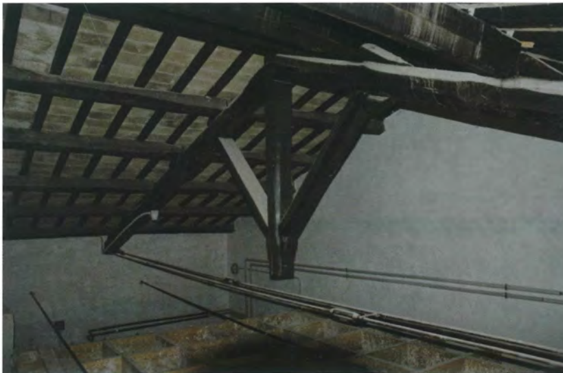
Fig. 4.106 - Teatro di Sirolo (AN). Piccolissimo intaglio nel puntone per accogliere la saetta.
