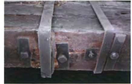
Fig. 4.103 – Particolare della giunzione con chiavarde della catena del Teatro Comunale di Chiaravalle (AN).
