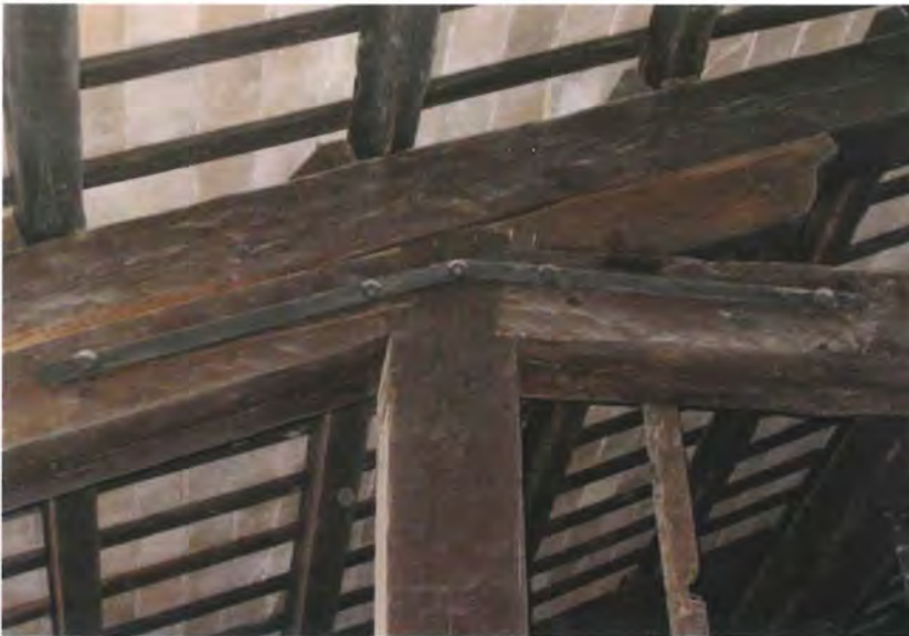
Fig. 4.95 - Teatro di S. Ginesio (MC). Presenza di una sottomisura in legno sopra il monaco a rafforzamento del nodo.
