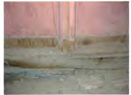
Fig. 4.25 - Particolare dell'aggancio tra candela e corrente in legno del basamento del Teatro Del Trionfo di Cartoceto (PU).
