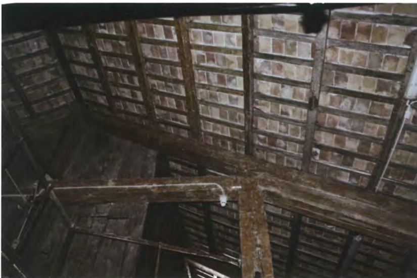
Fig. 4.93 - Teatro Serpente Aureo di Offida (AP). Oltre all'intaglio nel monaco è presente una staffa metallica per scongiurare eventuali distacchi del sottopuntone.
