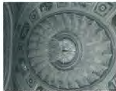
Fig. 2.4 – Teatro "Pergolesi" di Jesi (AN): plafone camorrcanna a copertura della sala. Il soffitto della sala volta ribassata ovale con al centro un rosone traforato decorazioni a riquadri che racchiudono scene agresti motivi floreali.
