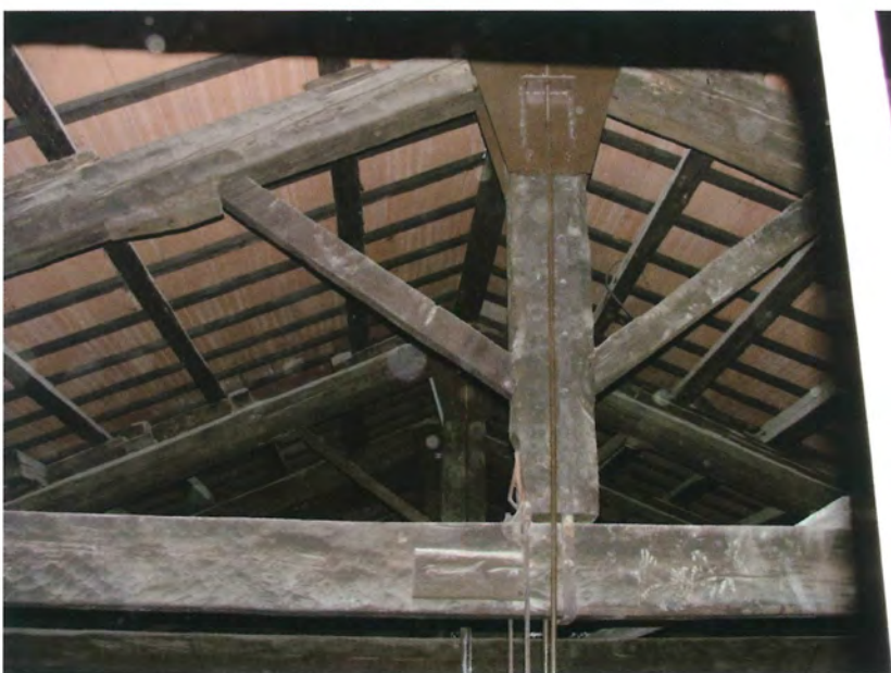
Fig. 4.108 - Teatro Ferrari di S. Marcello (AN). Né il monaco né il puntone risultano intagliati. L'unione avviene mediante sottomisure lignee.
