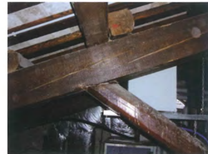
Fig. 4.106 - Teatro di Sirolo (AN). Piccolissimo intaglio nel puntone per accogliere la saetta.
