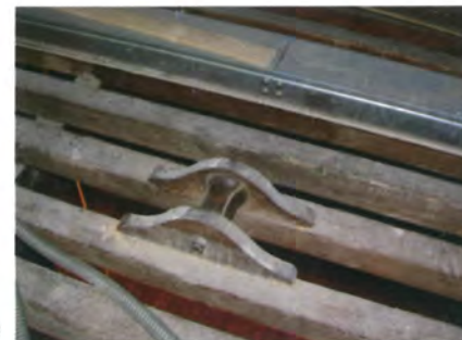
Fig. 6.8 – Teatro di Montemarciano (AN). Particolare della guida in legno posta sul graticcio per la movimentazione delle corde.
