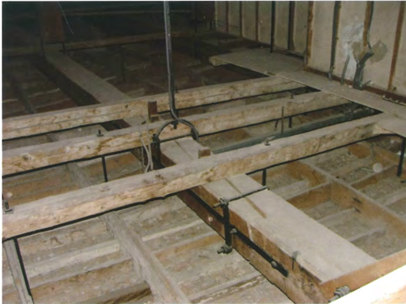
Fig. 4.99 - Teatro di Osimo (AN). Particolare della catena.
