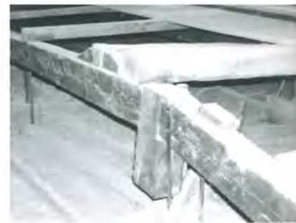
Fig. 3.3 – Esempio di sottostruttura inserita per sorreggere il plafone. Teatro Serpente Aureo di Offida (AP).
