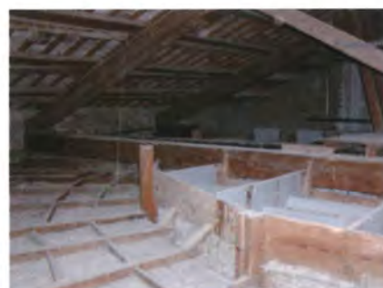
Fig. 4.38 – Il nodo candela – sistema di plafonatura. Teatro di Montecarotto (AN).
