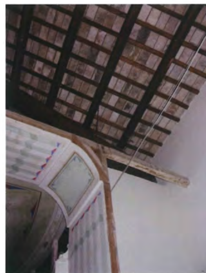
Fig. 4.62 e Fig. 4.63 – Boccascena del Teatro Del Trionfo di Cartoceto (PU). Dalle immagini si nota bene la struttura in legno con cui è composto.
