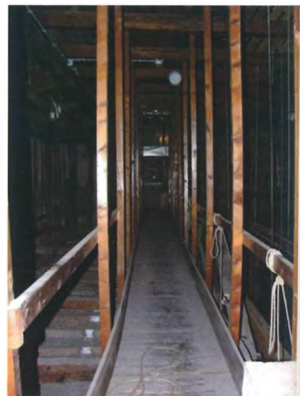
Fig. 6.12 – Teatro di Jesi (AN). Passerella sospesa alle strutture di copertura.
