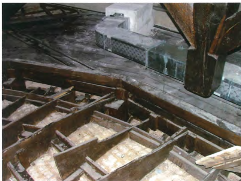
Fig. 4.38 – Il nodo candela – sistema di plafonatura. Teatro di Montecarotto (AN).
