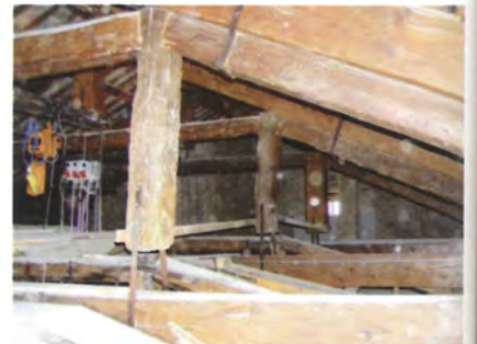
Fig. 4.93 - Teatro Serpente Aureo di Offida (AP). Oltre all'intaglio nel monaco è presente una staffa metallica per scongiurare eventuali distacchi del sottopuntone.
