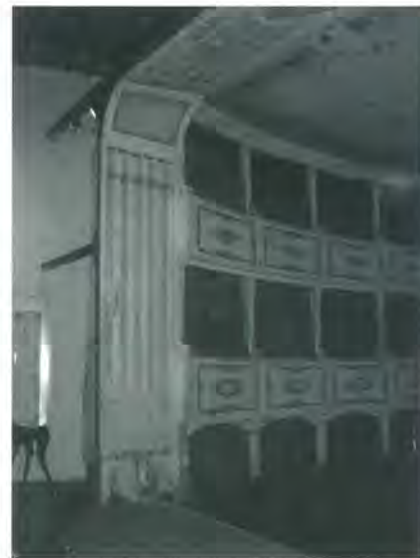
Fig. 5.10 - Arco di proscenio, Teatro del Trionfo di Cartoceto (PU). Nei piccoli teatri l'arco di proscenio ha dimensioni ridotte, la voce dei cantanti giunge direttamente al pubblico, mentre l'effetto di riflessione dei suoni assume minore importanza.
