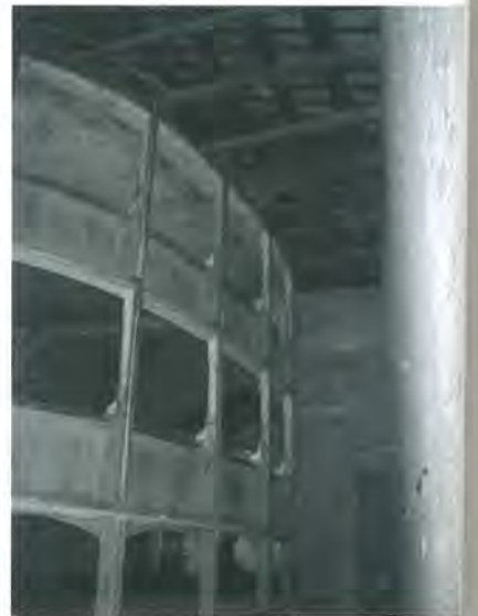
Fig. 4.12 e Fig. 4.13 – Il Teatro "Del Trionfo" di Cartoceto (PU). Come si vede dalle immagini attualmente all'interno del teatro è presente l'originaria struttura in legno dei palchetti e del plafone ad esclusione dei solai e delle pareti divisorie.
