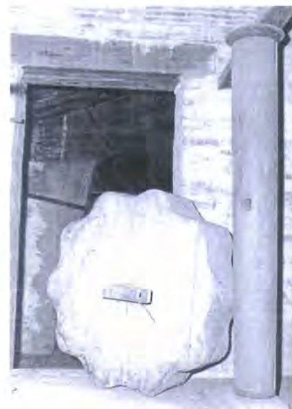
Fig. 6.3 - Teatro Comunale di Chiaravalle (AN). Macchinario originale utilizzato in passato per riprodurre il rumore della grandine (fonte: Ufficio Tecnico del Comune di Chiaravalle).
