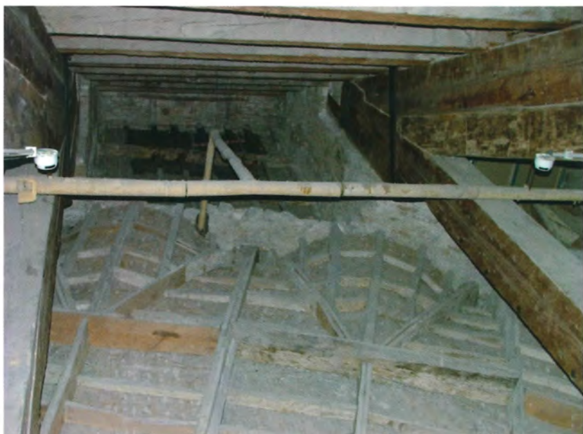
Fig. 4.58 – Grazie alla estrema versatilità del sistema a centine e camorcanna è possibile realizzare le più svariate conformazioni di soffitti per la sala. Nell'immagine a fianco un esempio di realizzazione di lunette del Teatro Gentile di Fabriano (AN).
