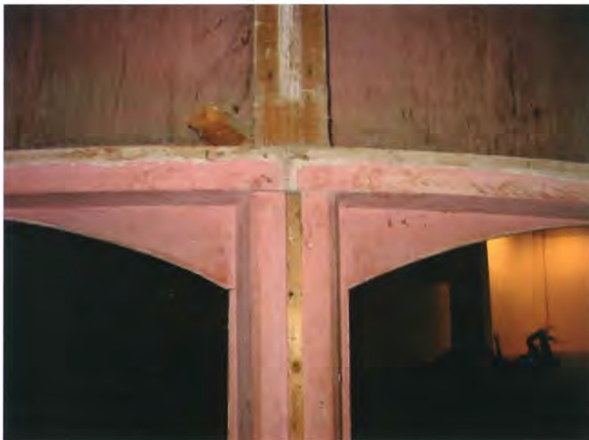
Fig. 4.28 - Particolare proposto dal Breyman per il nodo traverse – ritto (Breyman, 1885, Tav. 74).
