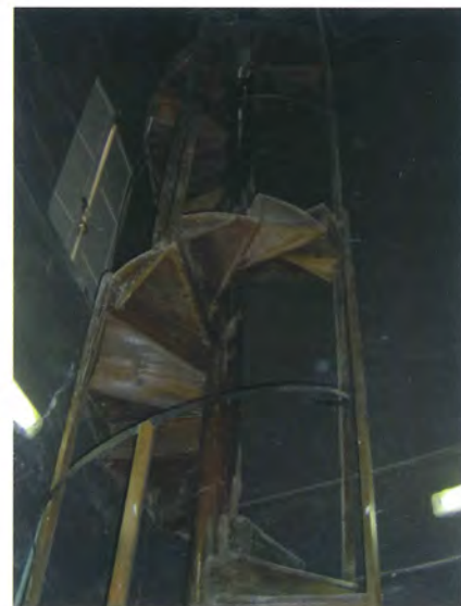
Fig. 6.11 – Particolare della scala a chiocciola in legno, posizionata in un angolo di palcoscenico, che collega quest'ultimo con il graticcio. Teatro di Chiaravalle (AN).
