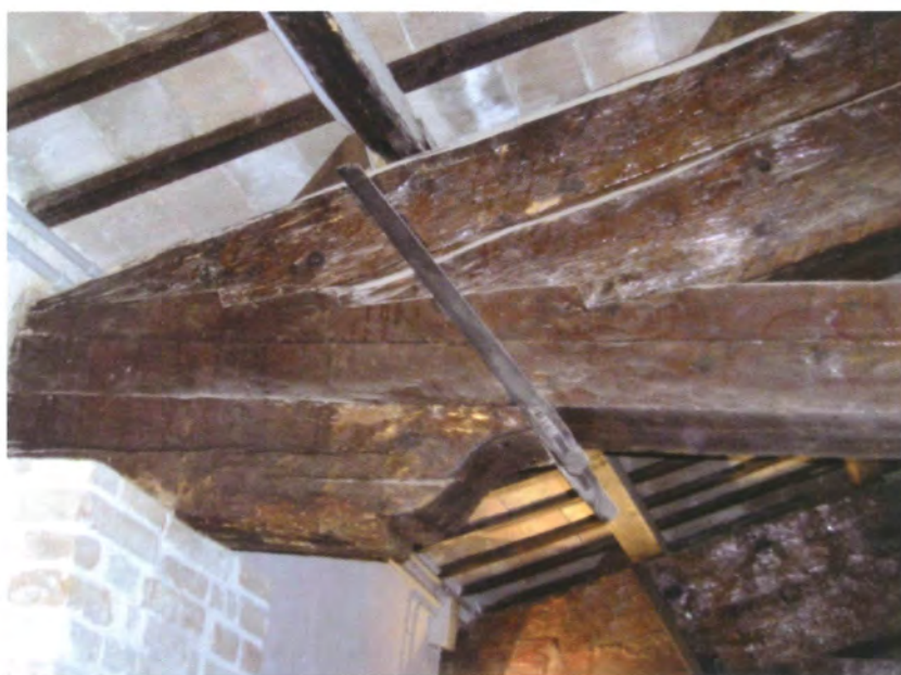
Fig. 4.85 - Teatro di Chiaravalle (AN). Unione a doppio dente per il sottopuntone e a semplice dente cuneiforme per il puntone.
