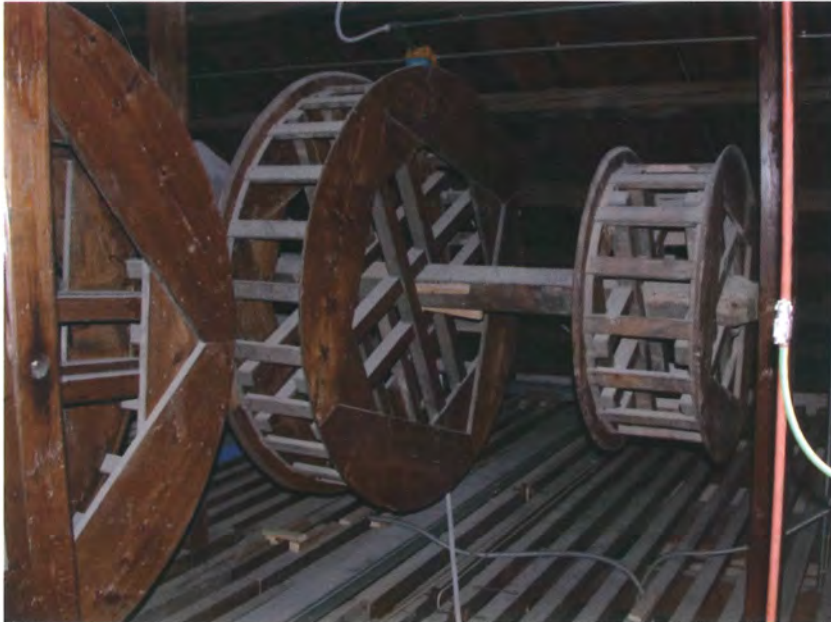
Fig. 6.23 – Ruote in legno poste sul graticcio del palcoscenico del Teatro di Cagli (PU).
