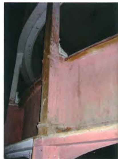
Fig. 4.35 – Particolare della sottomisura in legno inserita tra candela e parapetto. Teatro del Trionfo di Cartoceto (PU).
