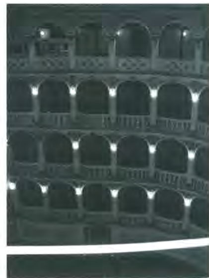
Fig. 4.10 – Teatro Lauro Rossi di Macerata. La sala principale ha pianta a forma di campana, i palchi sono a tre ordini, più il loggione, interamente realizzati in legno.
