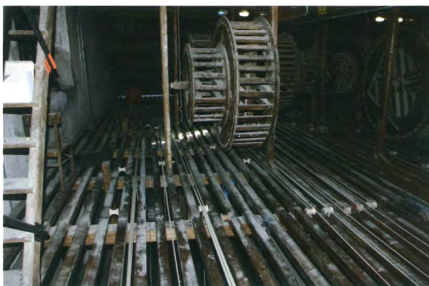
Fig. 6.8 – Teatro di Montemarciano (AN). Particolare della guida in legno posta sul graticcio per la movimentazione delle corde.
