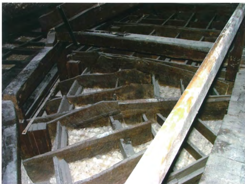
Fig. 4.57 – Teatro di Arcevia (AN). Si nota lo schema a raggiera delle centine realizzate con tavole grossolanamente squadrate.
