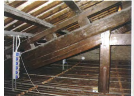
Fig. 4.91 - Teatro La Nuova Fenice, Osimo (AN). Doppio intaglio nel monaco che accoglie il sottopuntone e la controcatena.
