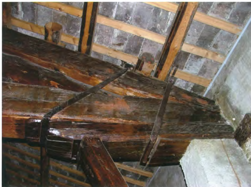
Fig. 4.86 - Teatro di Jesi (AN). Da notare la particolare soluzione per rinforzare il nodo puntone-catena con l'inserimento di una mensola e di un puntone in legno all'appoggio.
