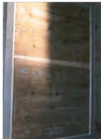
Fig. 4.44 - Particolare divisorio in legno presente alla data 1987 nel teatro L. Rossi di Macerata (immagine da Ufficio Tecnico Comunale).
