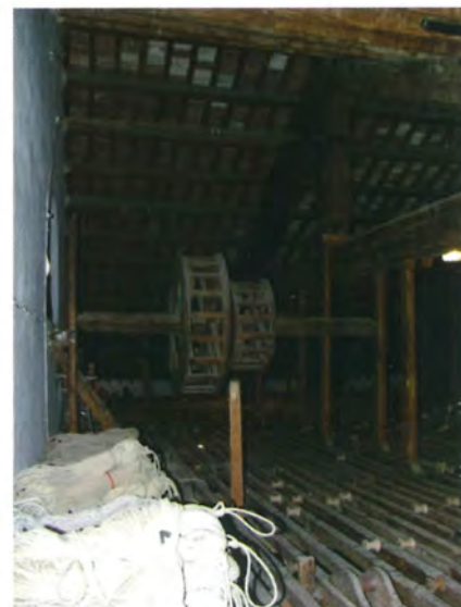
Fig. 6.21 - Ruote in legno poste sul graticcio del palcoscenico del Teatro di Fabriano. Da notare anche i "rocchi" e le guide per le corde poste tra i travetti del graticcio.
