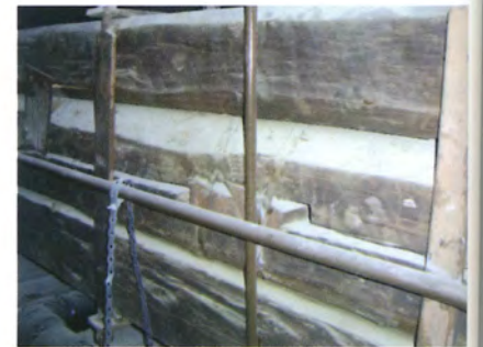
Fig. 4.101 - Teatro Lauro Rossi, Macerata. Catena composta da due elementi separati fasciati con bandelle metalliche. La giunzione avviene mediante sovrapposizione sopra e sotto la discontinuità di due elementi in legno forzati da staffature metalliche a vite.
