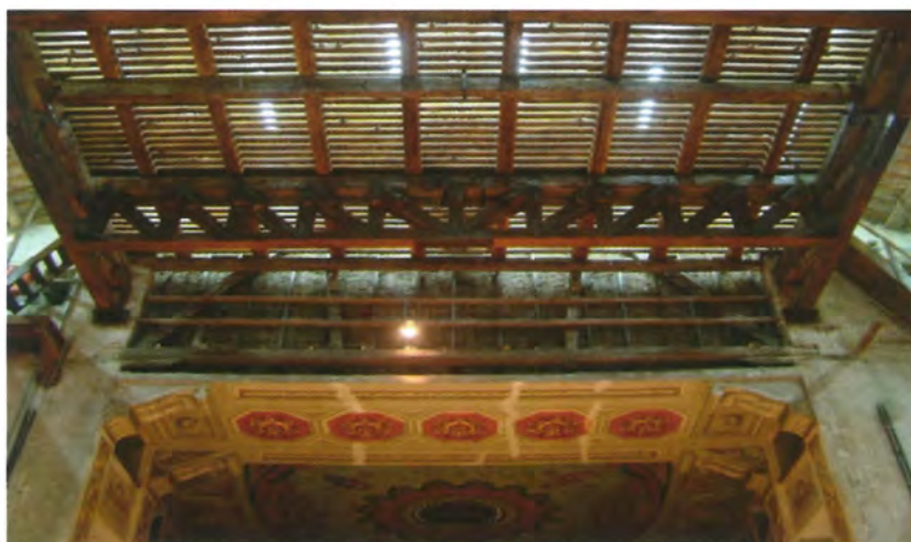
Fig. 6.7 – Teatro di Persiani di Recanati (MC). Intradosso della struttura armata del graticcio. Da notare anche la struttura in legno del boccascena.
