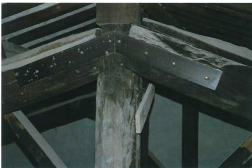
Fig. 4.89 - Teatro di Sirolo (AN). Unione a dente semplice rinforzata da fasce metalliche collegate in entrambi i lati.
