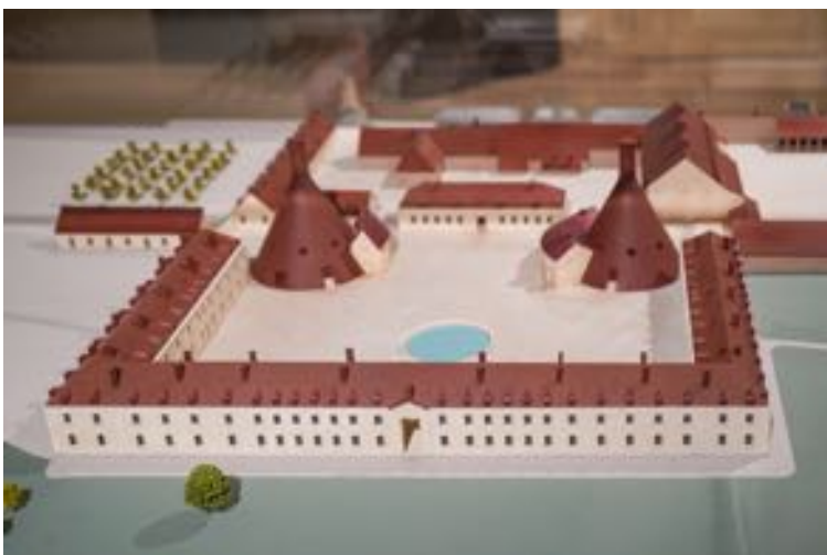
Abb. 3: Miniaturmodell des Kristall-Schlusses mit den beiden konischen Schmelzöfen
