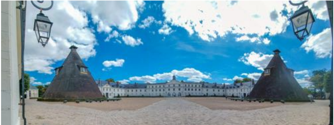
Abb. 4: Innenhof des "Château de la Verrerie"
