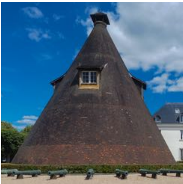
Abb. 5: Der östliche Glashüttenturm mit dem Theater, im Vordergrund Kanonen aus der Schneider-Stahlfabrik"
