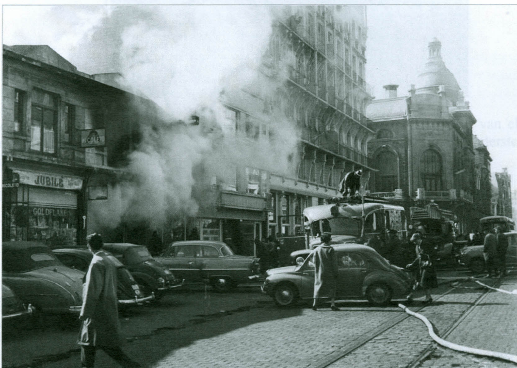
Fig. 13 : Brand in de Van Iseghemlaan met op de achtergrond het theater (foto Luc)
